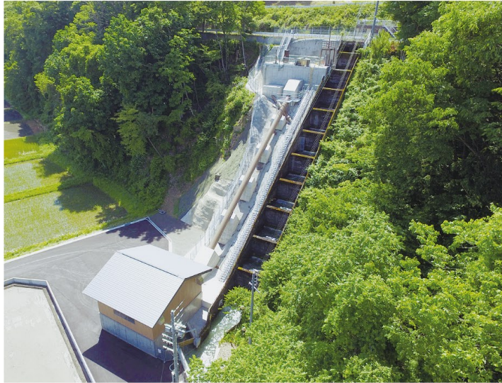
小水力発電所 | 業界: 農業用水 範囲: 設計・施工・土木・建築・発電・機械 出力: 197.8kw
