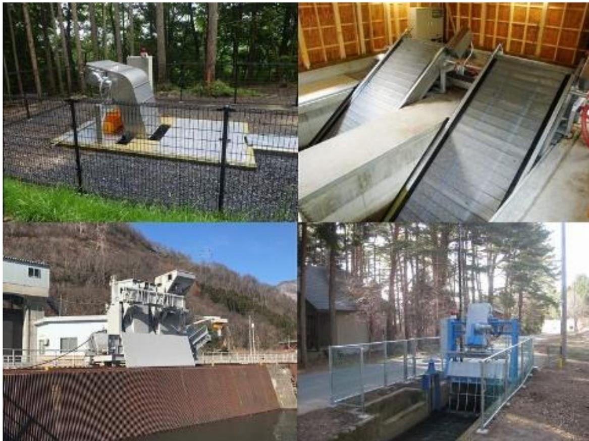
当社では、レーキ式からネット式、ワイヤーロープ式、アーム式、定置式、移動式など多数の除塵機の製造実績がございます。除塵機は、その設置環境や用途によって大きく設計が異なります。例えば、水路径間や水路高のような土木構造から、ゴミの量、掻揚荷重、スクリーン勾配、設計水位差、流速、掻揚速度等の設計条件によって、最適な除塵機の種類も異なります。
